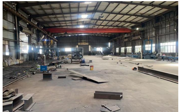
厂房内现状照片
