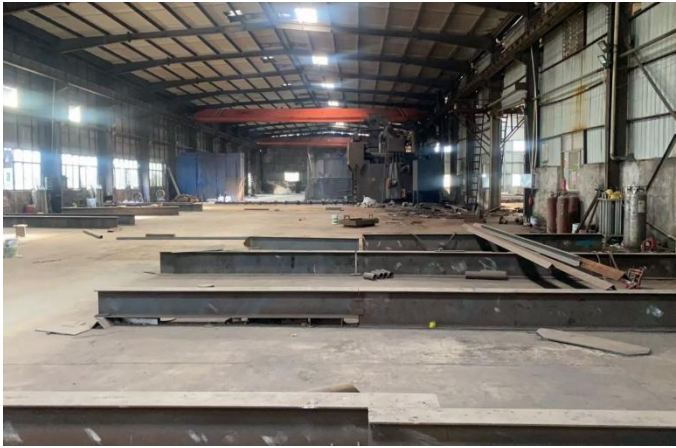
厂房内现状照片
