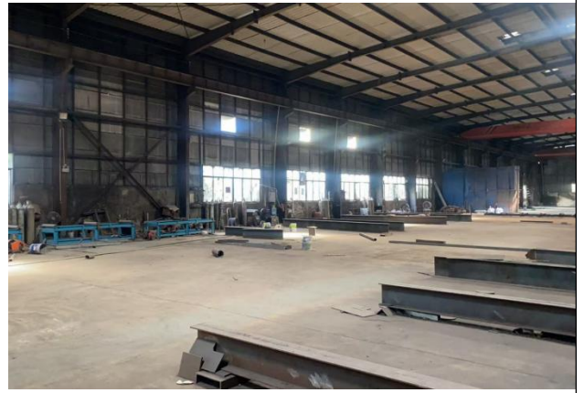
厂房内现状照片
