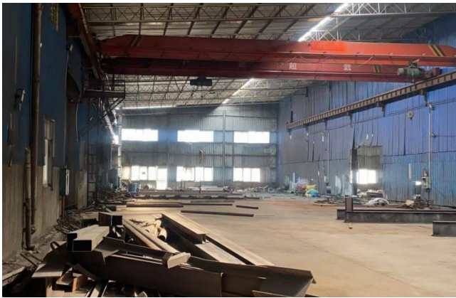
厂房内现状照片
