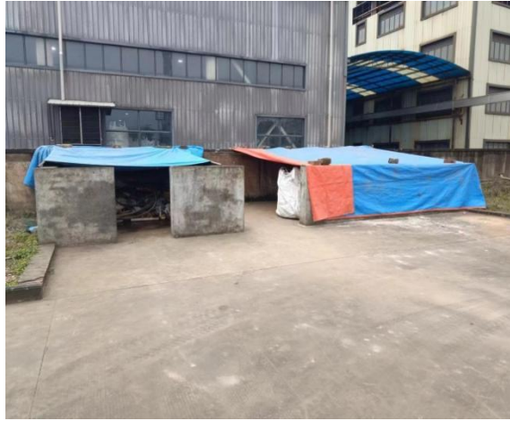
一般固废暂存间
