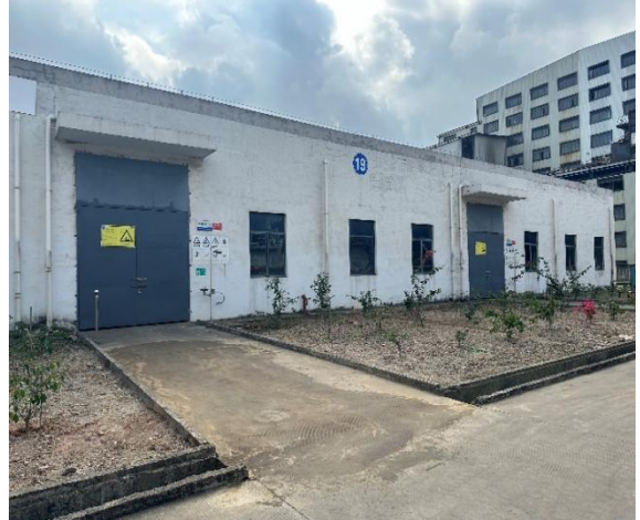
危险废物暂存间
